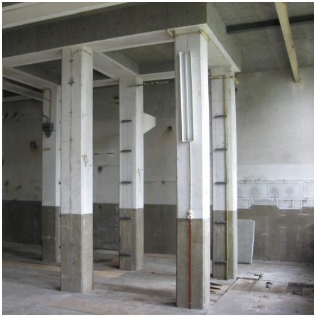
Nach Abbruch von Stützen werden die Deckenaufleger erstellt
