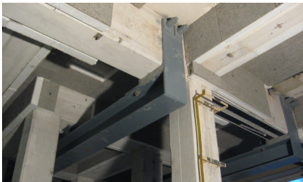
Abfangung der Decke in Stahl
