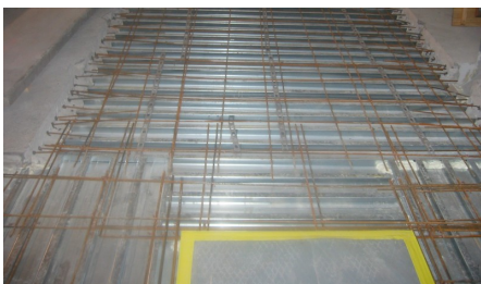
Stahlbetonverbunddecke aus Holorib und Überbeton C30/37
