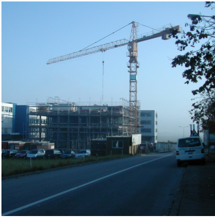
Südwestansicht der Baustelle
