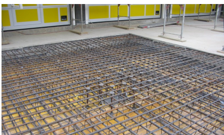
Durchstanzbewehrung einer Stütze
