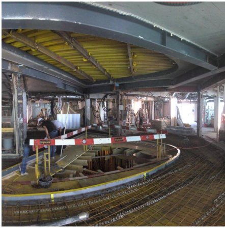
Einbau des Lichthofes, Seite Haupteingang
