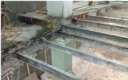
Abbruch im Bereich des neuen Lichthofes, Seite Sihlstrasse
