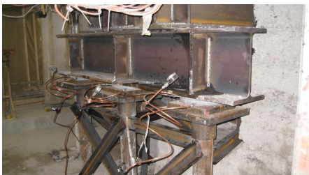
Stützenabfangung / Erstellung eines neuen Fundaments mit Mikropfählen
