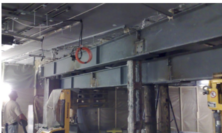
Stützenabfangung über neuer Bodenöffnung
