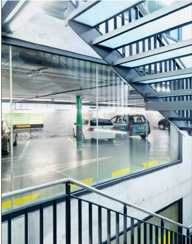
City Parking (Gessnerallee), Zürich Treppenaufgang
