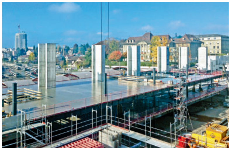
Oben TP II, Reiterbau, Montage der Wabenträger
