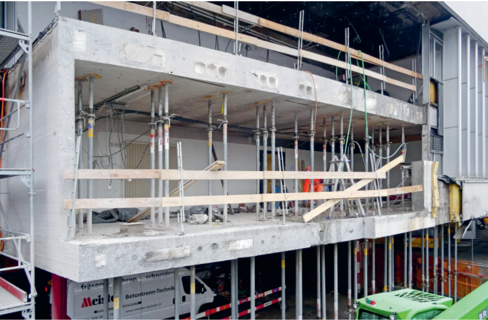
TP VI b, Anpassung Fassade GSA6, Abbruch der Betonscheibe
