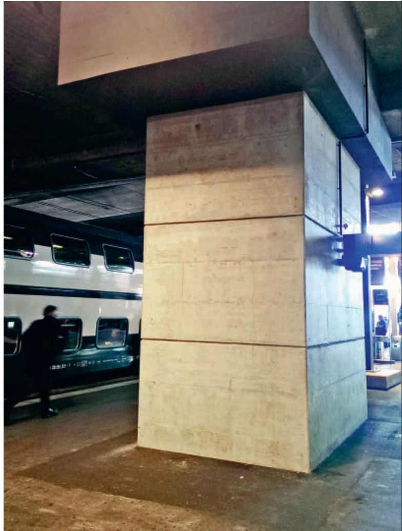
TP II, Reiterbau, neue Betonfeiler
