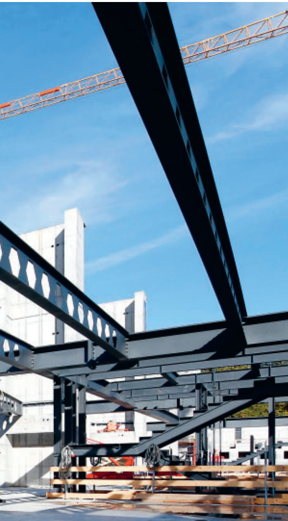
TP II, Reiterbau, Ebene 04, Wabenträger © PostParc, Foto Philipp Zinniker
