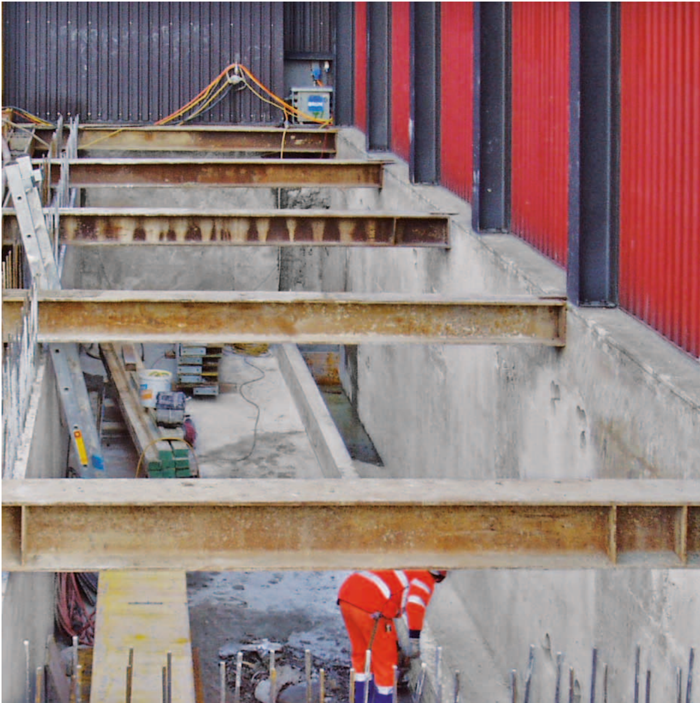
Stahl-Verbundpfähle (HEA 140) verbaut.
