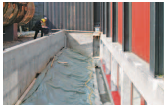
12 Neuer Lichtschacht vor der Halle SST im Bauzustand
