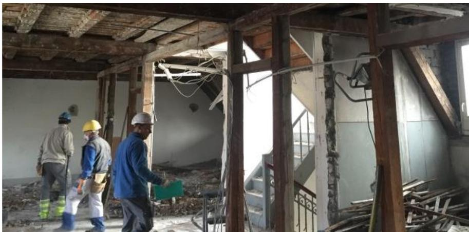
Die um 1920 erbaute Häuserzeile Bertastrasse besteht aus drei Gebäudeteilen mit je 6 oberirdischen Geschossen (einschl. Estrich). Die Geschossdecken sind als Hourdisdecken konzipiert und die zweigeschossige Dachkonstruktion (5. Obergeschoss und Estrich) als Kehlbalkendach.
