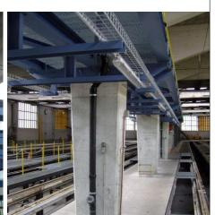
Im Tramdepot Wollishofen waren bislang keine Galerien für die Dacharbeiten an den Trams installiert. Mit der neuen Tramgeneration Typ Cobra sind Dacharbeitsplätze jedoch zwingend notwendig, da die meisten Apparate auf dem Dach angeordnet sind. Gelöst wurde dies durch Anbringen von zwei angehängten Seitenbühnen. Sie ermöglicht eine sichere Zugänglichkeit der Wartungsflächen "Tramdächer" und somit wurde die Arbeitssicherheit stark erhöht.
