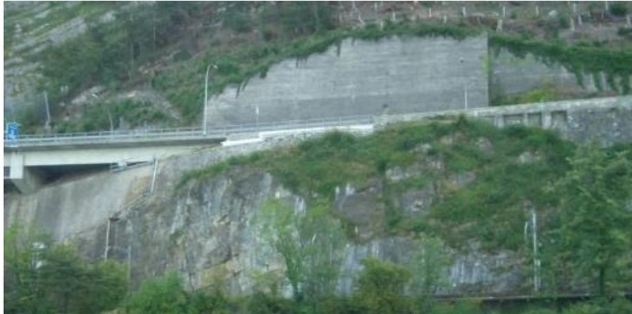
Im Rahmen des Massnahmenkonzeptes für die Instandsetzung der Anschlussbauwerke (AB) beim Südportal des Mositunnels in Brunnen SZ (A4/32), wurde die bergseitig verankerte Stützmauer einer Überprüfung gemäss ASTRA-Richtlinie unterzogen.
