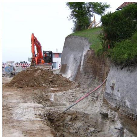
Um die Verkehrssicherheit zu erhöhen, wurde die Linienführung der Kreuzbuchstrasse angepasst und teilweise verbreitert. Hierzu wurden drei max. 4.5 m hohe Schwergewichtsmauern aus Granitblöcken erstellt. Eine temporäre Hangsicherung gewährleistete die Sicherheit im Bauzustand. Die untenliegenden Stützmauern wurden mit einer ca. 25 cm hohen Betonbrüstung versehen, auf der ein Geländer montiert ist.
