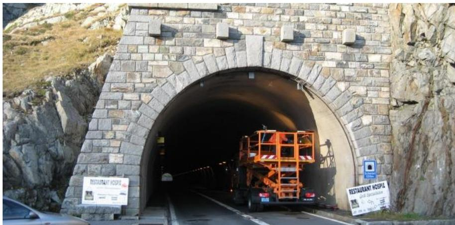
Die gesamte Tunnellänge auf dem Kantonsstrassennetz des Kantons Uri beträgt mehrere Kilometer, verteilt auf über 20 Bauwerke. Die Tunnelgewölbe bestehen aus Ortbeton, Spritzbeton und Tübbing bzw. Verkleidungselementen. Ein Teil der Tunnels ist unverkleidet.
