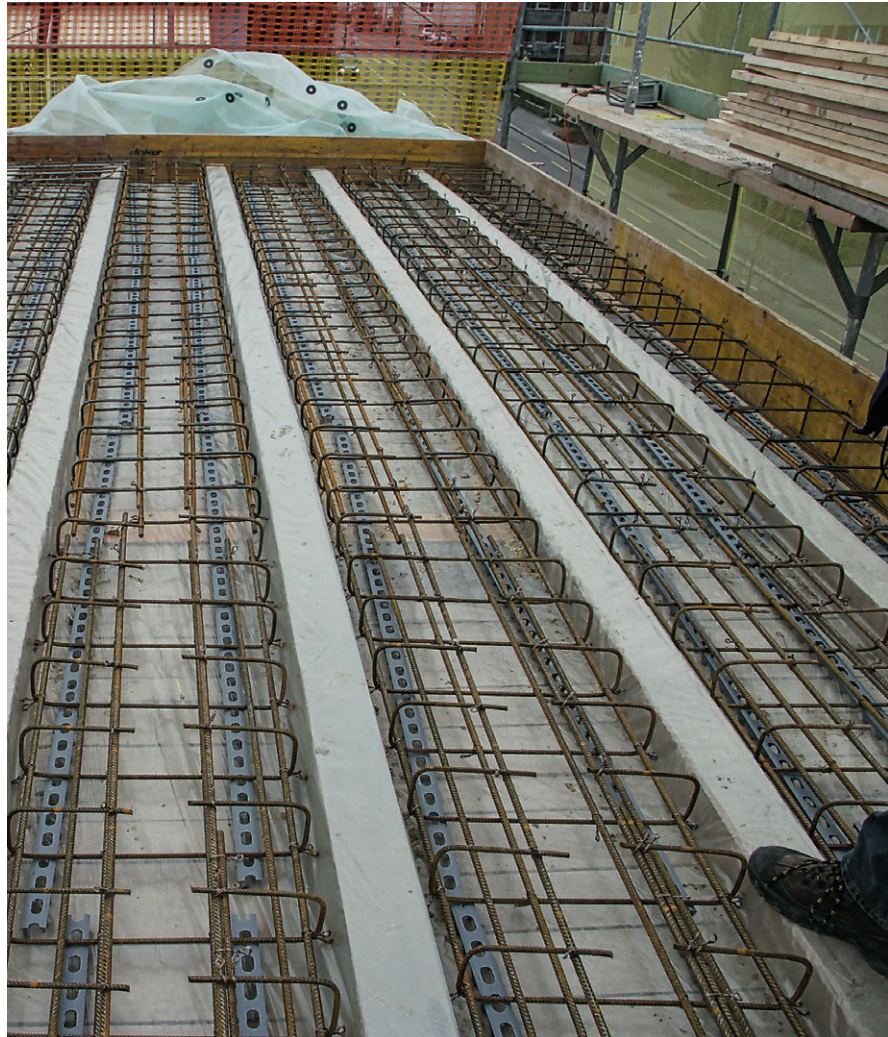
Abbildung 17A: Deckensystem kurz vor dem Betonieren
