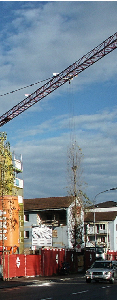
Abbildung 19: Ansicht der Überbauung. Links das erste sanierte Gebäude, anschliessend der Zwischenbau und rechts im Bild die Bestandesbauten
