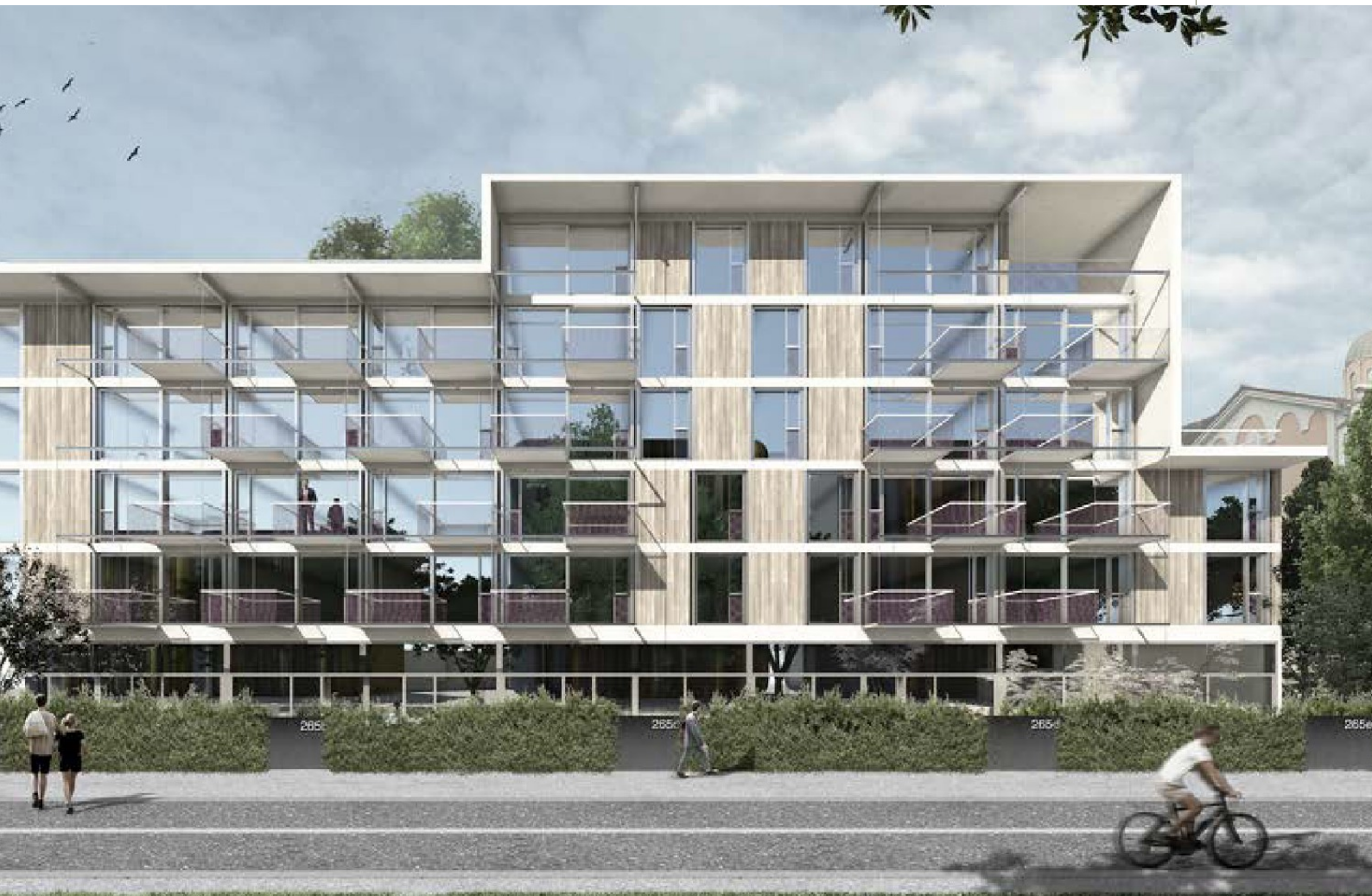
Abbildung 7: Bild linke Seite: Foto des Gebäudes vor dem Umbau. Bild rechte Seite: Visualisierung des Gebäudes nach Bauvollendung [MOKA Architekten].
