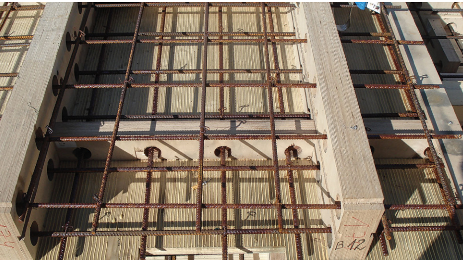
Abbildung 9: Das Top-Wall-System. Kanthölzer aus Fichtenholz mit der Abmessung von 120 / 200 mm [Google].
