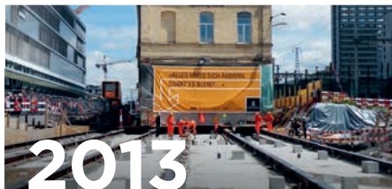
Gebäudeverschiebung Zürich Oerlikon
