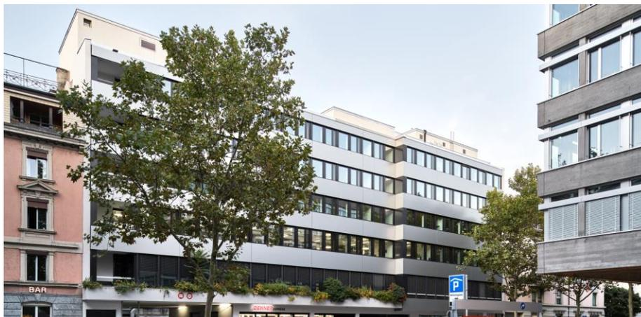
Das Gebäude wurde 1972 erbaut und bereits mehrfach umgebaut und saniert. Die bestehende Tragkonstruktion wurde in der Massivbauweise mit Stahlbeton und Mauerwerk realisiert. Die Skelettkonstruktion besteht aus Ortbetondecken, Ortbetonwänden und Stahlstützen. Die bestehende Tragstruktur wurde mit der nun ausgeführten Sanierung den heutigen Nutzerbedürfnissen und den geltenden Normen und Vorschriften angepasst. Die baulichen Eingriffe erstreckten sich über alle Geschosse des Bürogebäudes.
