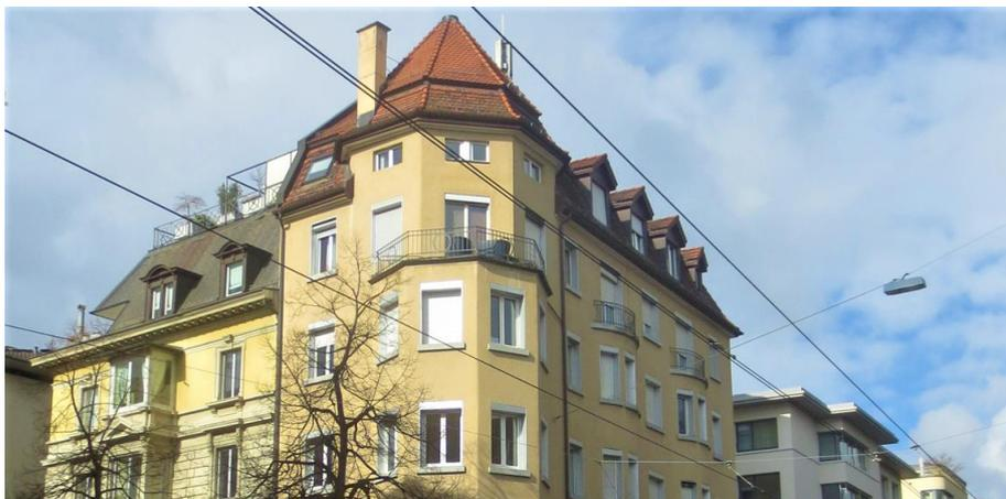
Das 5-geschossige Mehrfamilienhaus im Kreis 8 in Zürich wurde im Jahre 1908 erbaut. Die Tragstruktur besteht aus tragenden Mauerwerkswänden und Betonhourdisdecken (über UG und EG) resp. Holzbalkendecken (OGs). Das Dach ist als zimmermannsmässige Holzkonstruktion realisiert.
