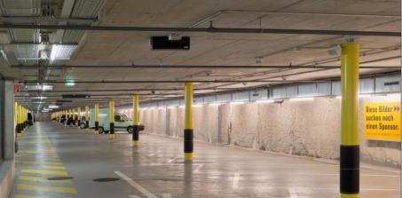
Beengte Platzverhältnisse, sensible historische Umgebung und die Aufrechterhaltung des Verkehrs an der Oberfläche waren die Rahmenbedingungen für den Bau des neuen Parkhauses unter der Gessnerallee in Zürich. Durch den mehrphasigen Bauvorgang in Deckelbauweise konnten im Sihlschotter 620 unterirdische Parkplätze als Ersatz für bestehende oberirdische Parkdecks erstellt werden.
